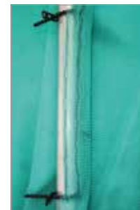
bild 70: Fastsättning av ställningsduk på ställningen
