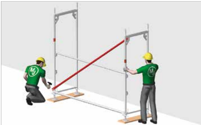
Bild 11: Montering av det första bomlaget: Vertikal-diagonal
