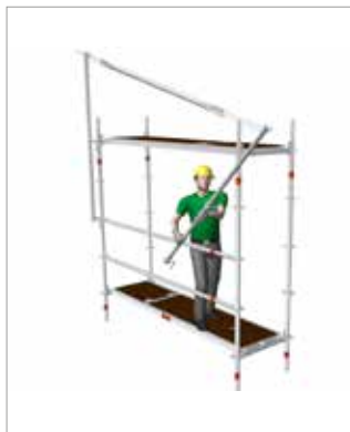
bild 57: Montering av den andra MSG stolpen komplett med skyddsräckesstag
