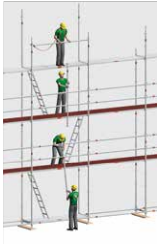
bild 39: Exempel 2 på montage av ställning med PFU
