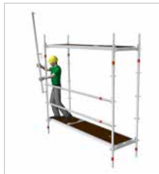
bild 55: Montage av första MSG posten
